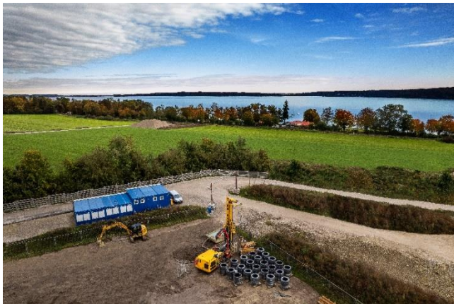
(1) Bauer Resources errichtet eine Erdwärmesondenanlage für Gymnasium in Dießen – mit spektakulärem Blick auf den Ammersee.
