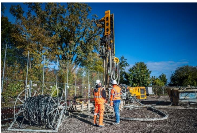
(2) Mit zwei leistungsstarken KLEMM KR 805 Bohrgeräten realisierten zwei Bohrteams rund 5.700 Bohrmeter.
