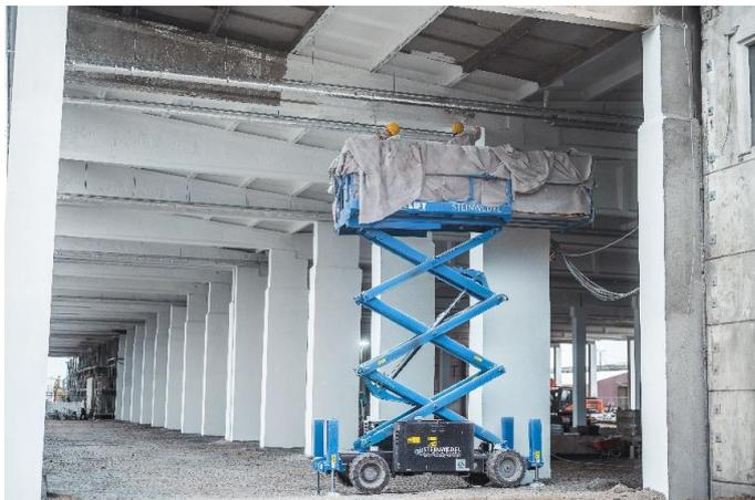
(2) 500 m<sup>2</sup> Binderflächen wurden zunächst vorbereitet und anschließend mit einem Oberflächenschutzanstrich versehen.
