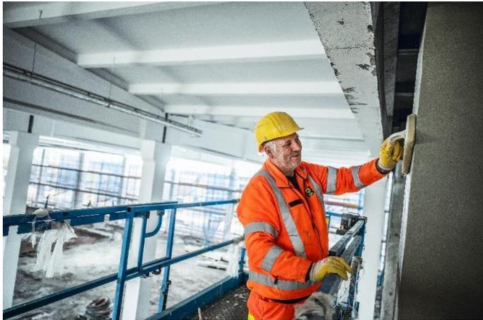
(3) Zur Finalisierung der Oberflächen wurde der Auftrag per Hand verrieben.
