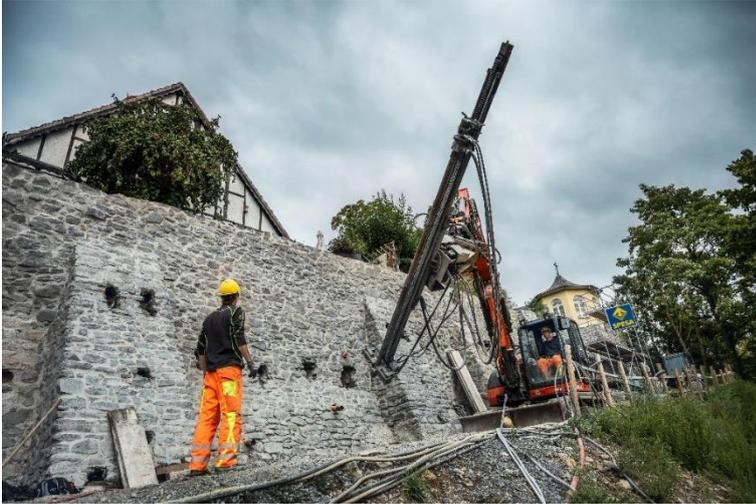
(3) Neben Injektionsbohrungen und Mauerwerksnadeln erfolgte die statische Sicherung mit Selbstbohrankern.
