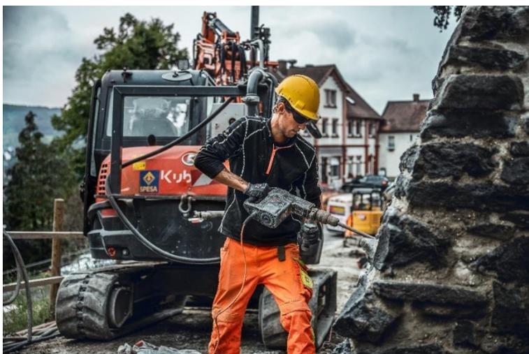
(2) Das Ausstemmen der vorhandenen schadhaften Mauerfugen auf einer Fläche von 400 m<sup>2</sup> zählte zu den aufwändigsten Arbeiten.
