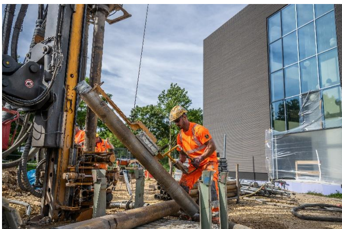
(2) 24 Erdwärmesonden wurden auf engstem Raum installiert.
