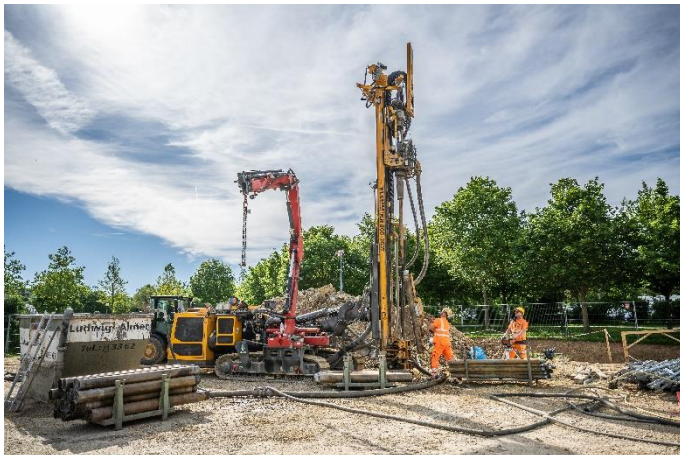
(1) Bauer Resources errichtete in neun Monaten eine Erdwärmesondenanlage für den neuen Modulbau auf dem Regensburger Hochschul-Campus.
