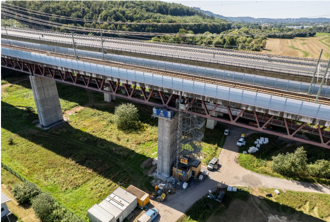
(3) Die Arbeiten an den Pfeilerköpfen wurden mithilfe von Hängegerüsten ausgeführt.
