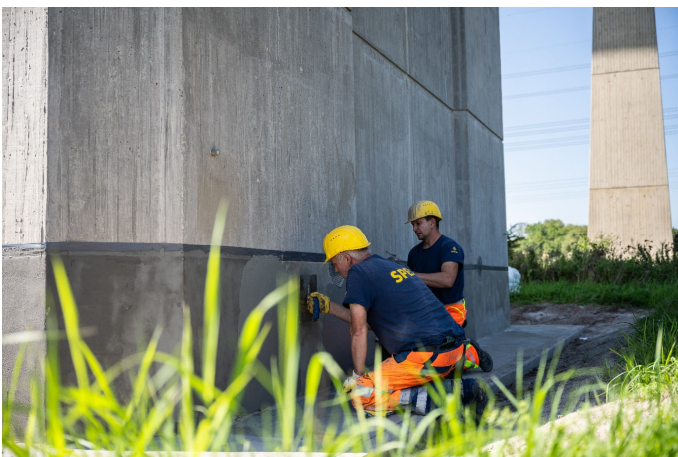
(5) Zum Schutz vor eindringender Feuchtigkeit wurden die Pfeilerfüße ebenfalls umfangreich behandelt.
