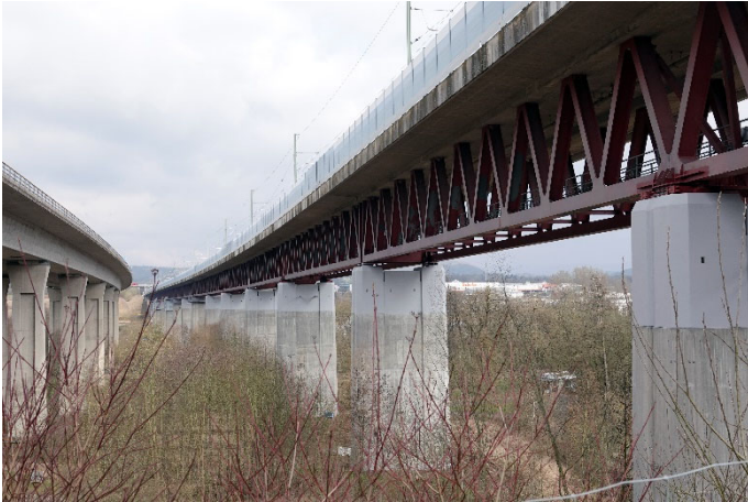
(6) Die frisch sanierten Pfeilerköpfe der Eisenbahnüberführung Itzthalbrücke.
