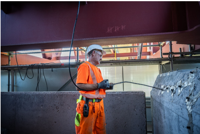
(4) Insgesamt wurden 2.000 m an Rissen verdämmt, verpresst und anschließend beschichtet.
