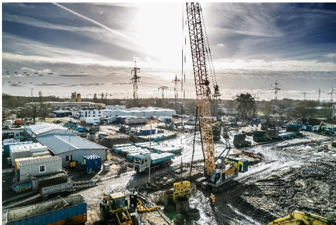
(1) Seit November 2023 saniert Bauer Umwelt ein ehemaliges Industriegelände in Velten, nahe Berlin.
