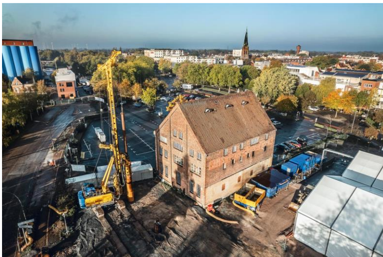
(1) Seit Juli 2023 saniert Bauer Umwelt ein ehemaliges Industriegelände in Elmshorn.
