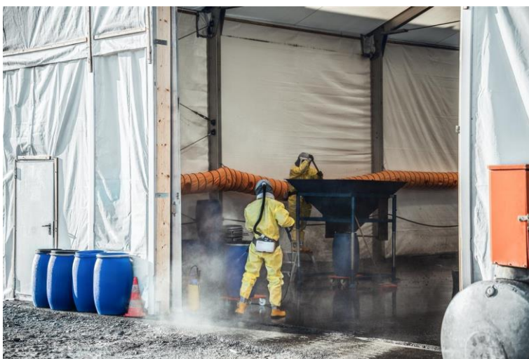
(2) Spezielle Schutzanzüge und eine Abluftreinigungsanlage dienen der Sicherheit von Arbeitern und Umfeld.
