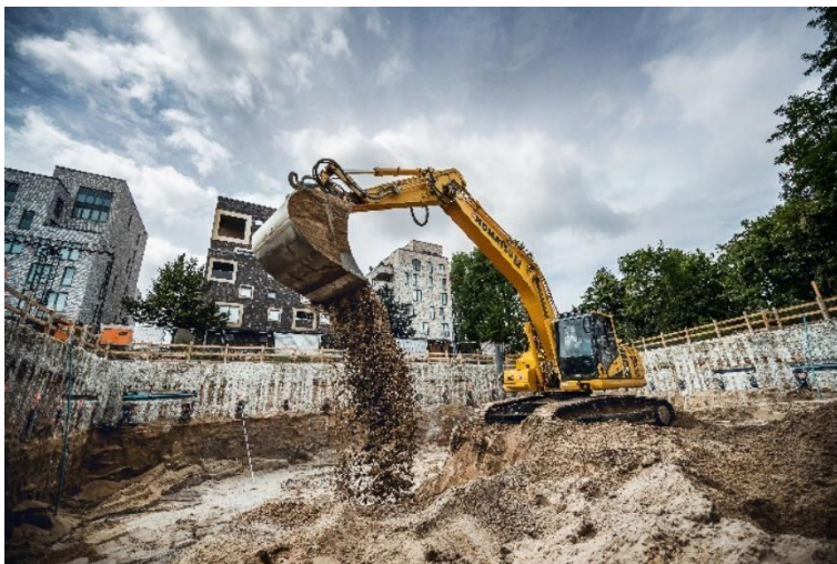
(2) In bis zu 8 m Tiefe erstellte Bauer Umwelt die Baugrube.
