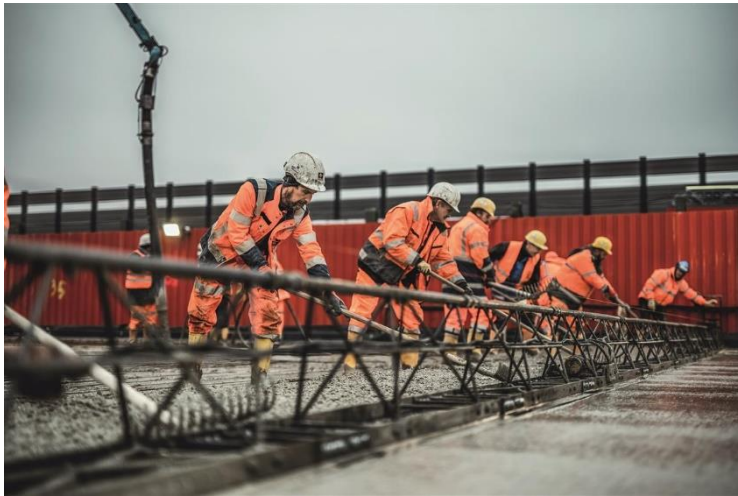
(3) Betoneinbau vor der Rüttelbohle zur Herstellung der Betonoberfläche
