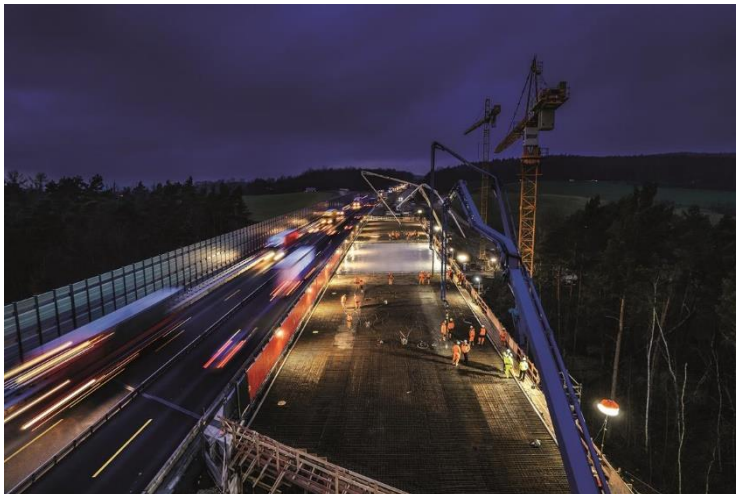
(1) Kraftakt: In nur einem Tag erfolgte im Dezember die Betonage für die Überbauten des zweiten Teilbauwerks der Innerstetalbrücke.
